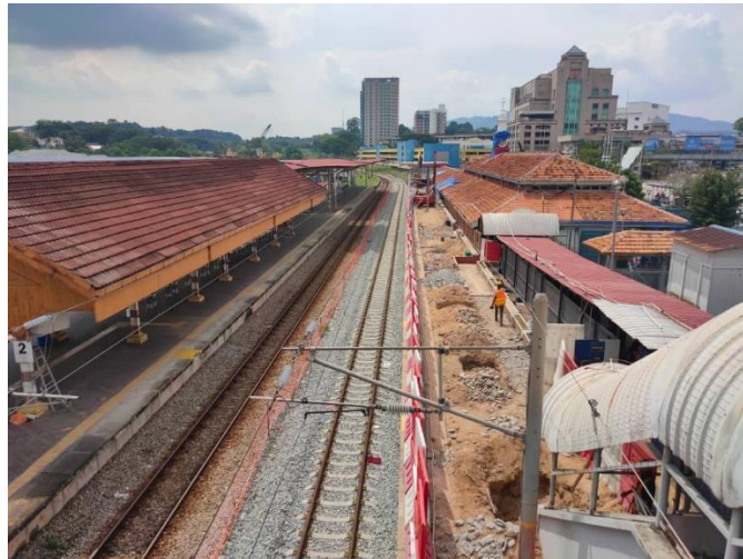
Kerja-kerja meroboh dan membina semula bumbung di Platform 1 Stesen Keretapi Seremban sedang giat dijalankan oleh pihak DMIA
