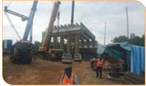
Gambar 9: Tumpang lalu bagi membina jambatan melintasi landasan kereta api di KM28.82 Cawangan Tanjung Pelepas, Johor oleh Jurutera Perunding Meinhardt Sdn Bhd (JPMSB) untuk Country Garden Pacificview Sdn Bhd (CGPSB)
