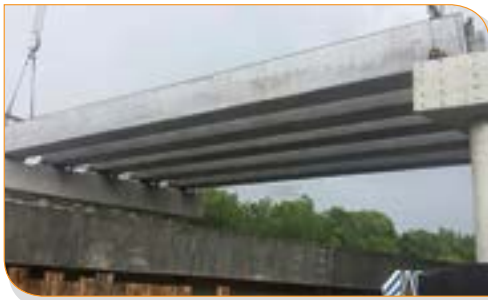
Gambar 9: Tumpang lalu bagi membina jambatan melintasi landasan kereta api di KM28.82 Cawangan Tanjung Pelepas, Johor oleh Jurutera Perunding Meinhardt Sdn Bhd (JPMSB) untuk Country Garden Pacificview Sdn Bhd (CGPSB)
