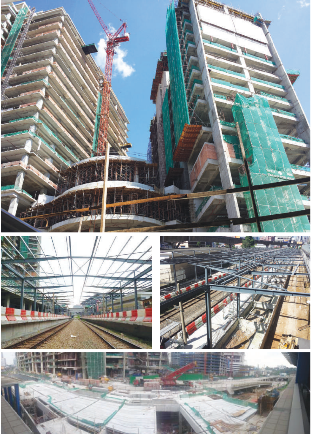
Gambar 30: Tapak projek Pembangunan Stesen Komuter KL Eco City.
