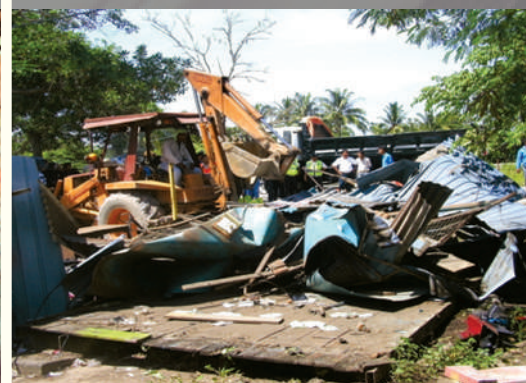
Kerja-Kerja perobohan sedang dijalankan. Kerja-Kerja perobohan sedang dijalankan. Demolition works in progress.
