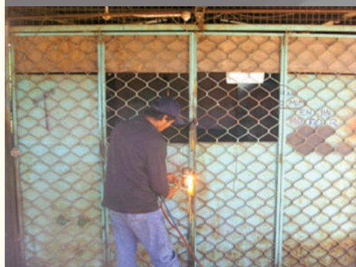
Anggota penguatkuasa memotong pintu sebuah bengkel motor yang terlibat dalam kawasan ROB. Bengkel tersebut perlu dirobohkan setelah gagal mematuhi notis yang dikeluarkan. Enforcer cutting through iron grills of a motorcycle workshop built on an ROB area. The workshop needs to be demolished after the owner failed to adhere to the notice.
