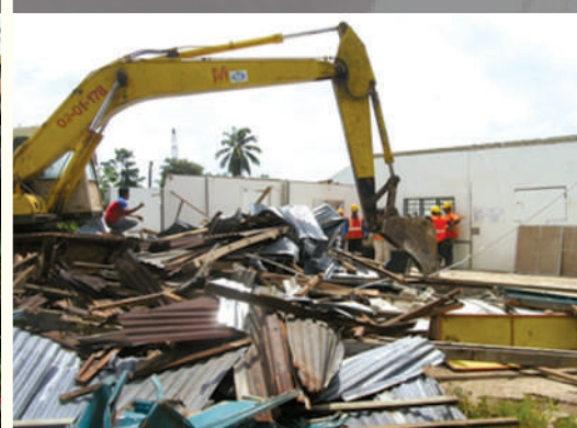
Jentera berat digunakan untuk kerja-kerja meroboh setinggan/penyewa yang enggan keluar. Heavy machinery used in the demolition of houses whose owner refuses to move out.
