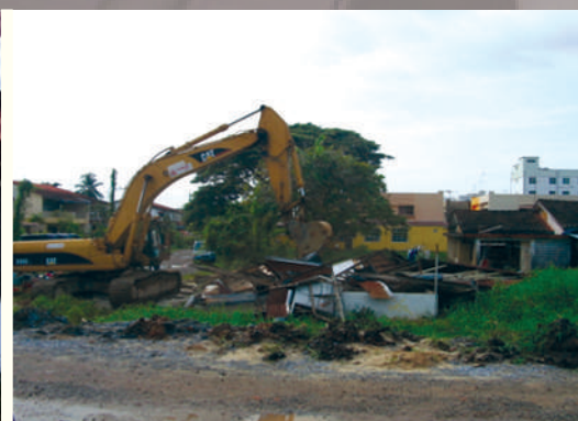
Kerja-kerja meroboh dilaksanakan menggunakan jentera berat oleh pihak kontraktor projek (penguatkuasaan hanya dilakukan kepada pemilik tegar yang enggan keluar walaupun notis telah dikeluarkan dan wang ex-gratia telah diberikan). Demolition works implemented by project contractor using heavy machinery (enforcement action will only be taken when the owner refuses to move out despite having received the notice and ex-gratia payment).
